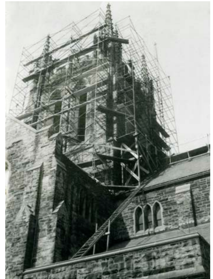
Réparation de la maçonnerie, 1986
